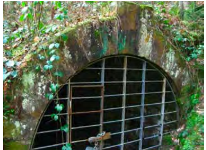
Bergbau in HD Stollen im Mausbachtal (Ziegethhausen).
