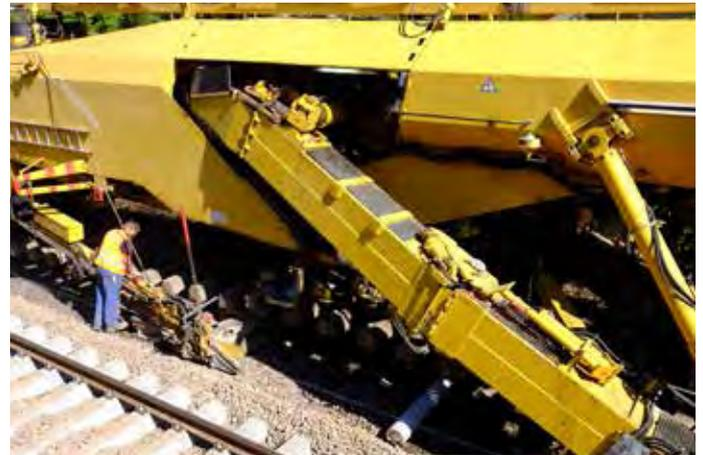
Die Gleise wurden angehoben und der neue Schotter untergeschoben.
