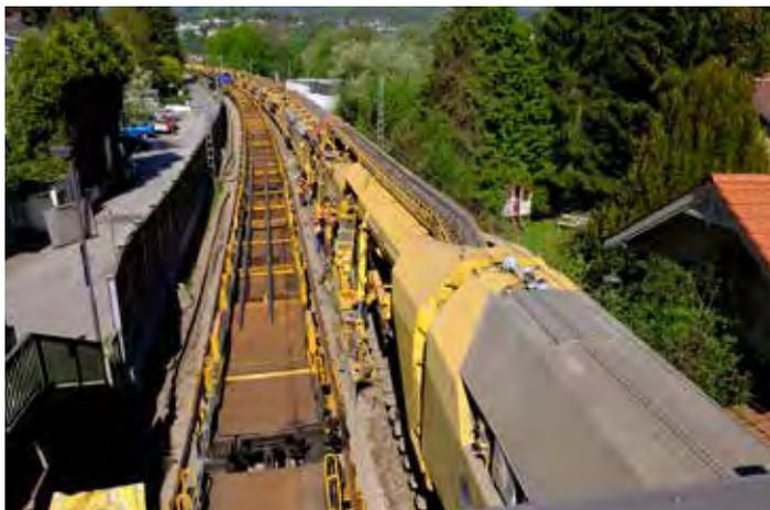
Auf der einen Seite werden die alten Schienen abtransportiert, auf der anderen wird der Schotter erneuert.
