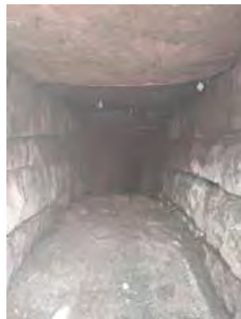
Blick in einen Quelltunnel
