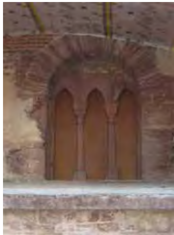
Bild 1: Wieder eingebautes Fenster im Veranstaltungsraum des „Gläsernen Saalbaus“
